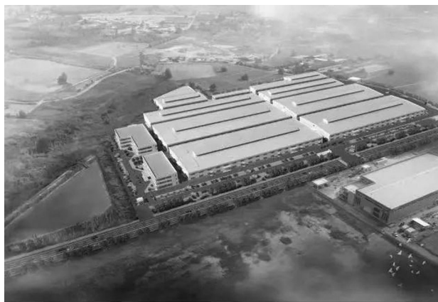
新大地(泰国)有限公司厂房(第一个海外EPC项目)
