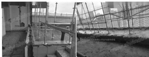
改造建筑拆除后的结构复核
