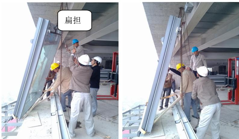
由于该单元幕墙系统为断开式，上下都是挑檐楼板，单元与楼板间间隙极小，所以不能采用通用的吊装工具。“扁担”的应用解决了间断式单元幕墙安装在吊具方面的难题。
