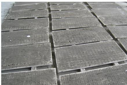
本工程卫生间墙面采用  $300\text{mm} \times 600\text{mm}$  玻化砖粘贴饰面, 由于玻化砖吸水率很低 ( $E \leq 0.1\%$ ), 而且背面光滑, 与基层粘贴不牢极易空鼓, 我们通过工艺改进, 采用新型胶粘
