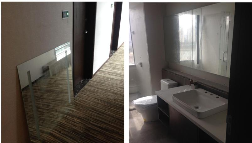
活动防雾镜体施工完成后（背面带灯带及防雾贴）的照片
