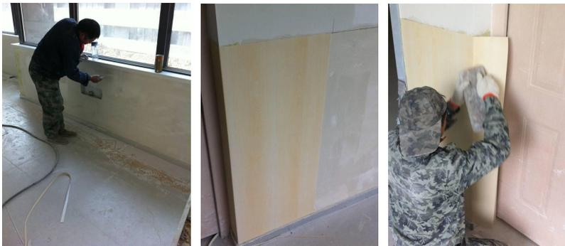
(4) 基层处理控制要点。墙面先涂刷界面剂增加腻子附着力，然后再用外墙防水腻子涂抹三遍并打磨，确保基层平整度。完成后的墙面基层使用靠尺进行测量，不放过任何一面墙，保证基层平整度误差小于等于 2mm；并按照既定目标绘制了细部深化节点图，以便于工人施工。
