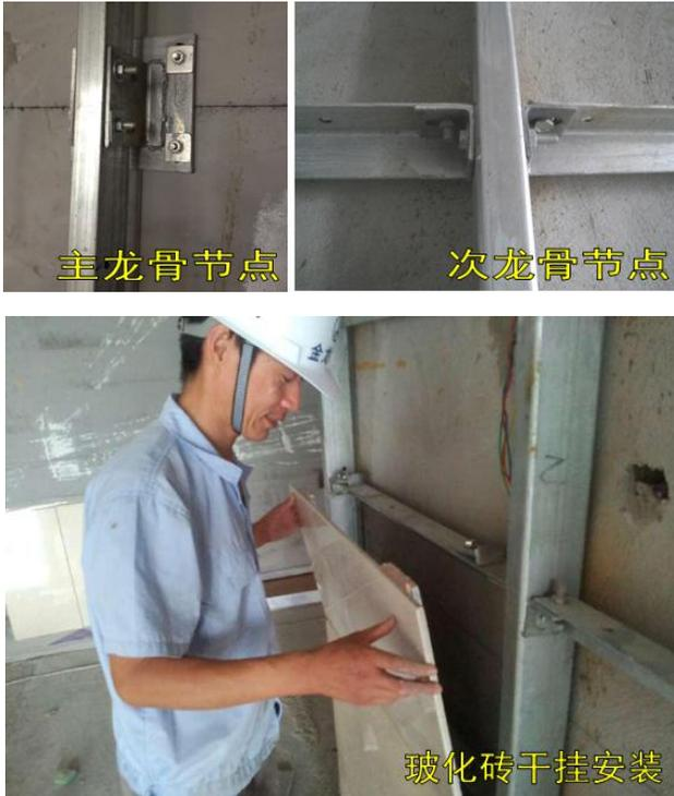
本工程墙柱面约 2000 多平方米的饰面砖采用了该项施工技术，设计选用的玻化砖规格为  $400\text{mm} \times 800\text{mm} \times 10\text{mm}$ ，上下磨“V”字边处理。“内墙模块式饰面板钢龙骨结构”这种新型的装饰技术，主要是应用于内墙饰面板装饰用钢材的标准化单元和重复使用等方面。与传统内墙饰面板装饰用焊接钢材相比，更具绿色环保性，可使施工现场无噪音、无污染、无油漆气味等，同时还具有施工质量可靠、综合成本低、工期缩短、提高建筑钢材的重复利用率等优点。
