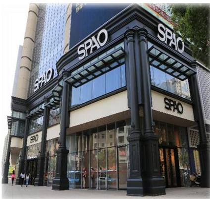
**提要：**本工程 1-8 层为框架幕墙，包括石材幕墙、玻璃幕墙、铝板幕墙等，9-12 层为单元玻璃幕墙，顶部钢结构造型包括铝板幕墙、玻璃幕墙和铝板百叶。本工程主体建筑造型具有强烈的时代特征，采用极具魄力和时代感的设计手法，使外装饰效果与建筑和谐统一。为充分体现这一建筑的功能和结构特点，公司在深刻理解主体建筑设计的思想内涵后，进行深化设计，既考虑了建筑的功能、造价及所具备的施工技术条件，又考虑了强度设计、隔音降噪设计、防火设计及防雷设计。
