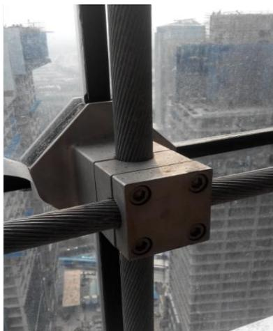
**解决方法：**拉索幕墙系统，位于4号楼南立面35F-46F，采用15+2.28pvb+15超白钢化夹胶镀膜玻璃，规格2175mm×2100mm，单块重约300kg，玻璃偏大、偏重，玻璃运输和幕墙安装难度较大。工人采用吸盘将玻璃搬运到水平运输架（每次只允许同时搬运两块玻璃），用绑带将玻璃与架体绑牢，并运送至塔吊起吊点，利用塔吊
