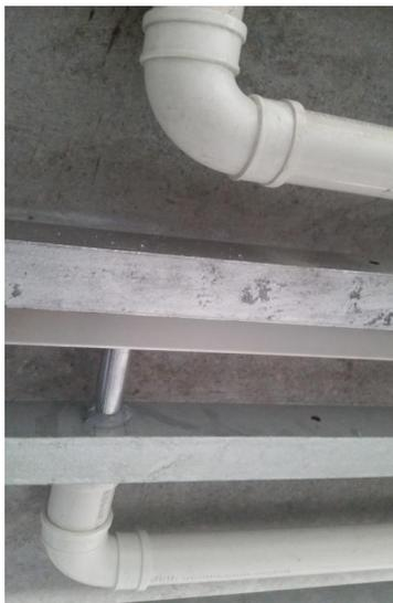
(6) 排水管道安装完毕后, 应对管道的外观质量和安装尺寸进行复核检查, 无误后再做通球试验。
