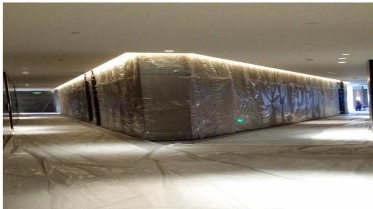
针对墙面硬包的成品保护，用薄膜全覆盖式保护，做到无灰尘、无交叉污染的情况发生。
