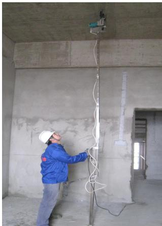
本工程采用镀锌螺杆作为吊杆，由于其规格品种齐全、安装调节方便、质量稳定可靠等因素，在现代建筑装饰装修吊顶和管线设备安装中得到广泛应用。但由于一般建筑天棚混凝土板底净高较高，安装吊杆均需采用高凳或脚手架等登高工具进行登高作业，登高作业大大降低了施工工效，且具有一定的安全隐患。为解决这一难题，我们根据本
