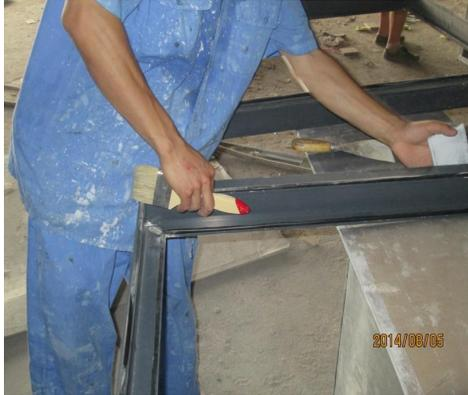
(5) 打磨结束后，油漆工进行三遍原子灰，然后打磨，三遍底漆，再次打磨，最后喷氟碳漆，晾干，清理。
