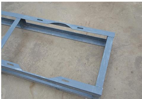
本工程采用了陶瓷台下盆施工与安装的新技术，工艺流程为：测量→钢骨架工厂制作→底部侧板安装→台面石材和侧板安装→台盆安装→打胶及清理。在已知台
