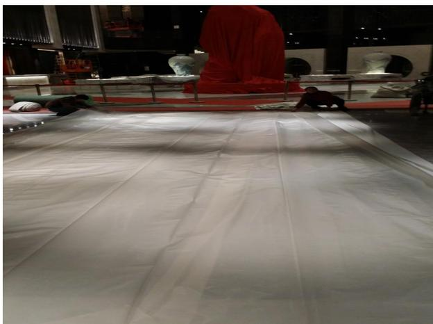
首层大堂地面鱼肚白石材的成品保护：石材比较娇贵且质地脆，用薄膜防止有水污染渗透下去，给石材造成损坏。
