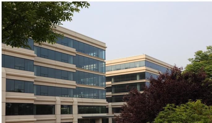
(3) GRC 新型绿色外墙系统，用以取代各类建筑的外围护结构，板面条形造型均匀，具备节能、节材、环保、防火、防水、隔音、抗震和寿命长等特点，把建筑一体化的功能和美观有机融合。
