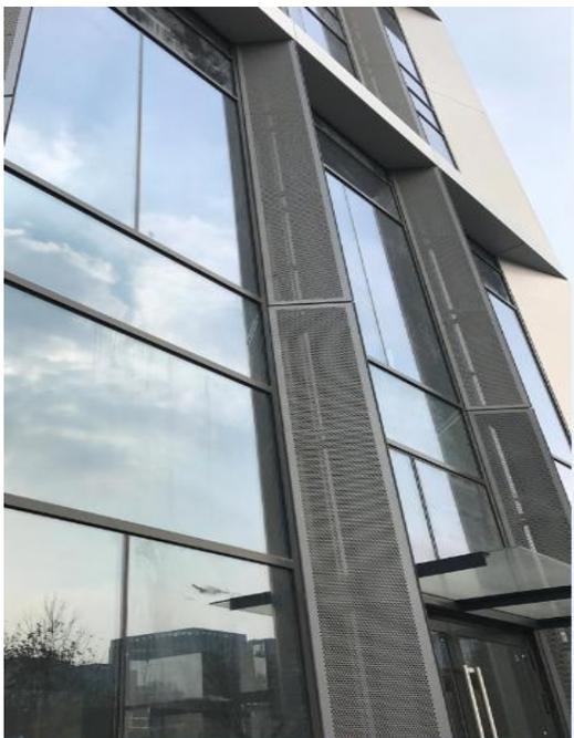
过调整翻窗型材局部开模尺寸和胶条开模，密封效果得到显著改善，误差较小部分采取微调垫高方法补救，误差较大部分采取更换材料来满足组装要求。
