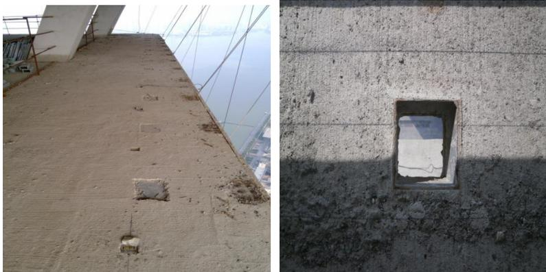
如上图所示，孔位处即为幕墙外表面位置，由于该系统幕墙表面位于主体结构外边缘以内 90 公分处，单元上下边缘与楼板间隙极小，无法在楼体外表面进行吊装，所以在项目初期，项目组织者就与业主及总包达成一致意见，在此处预留吊装孔。
