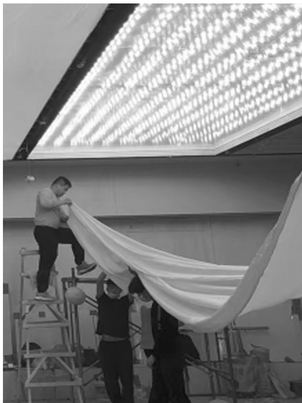
图 2.6 软膜安装现场图
