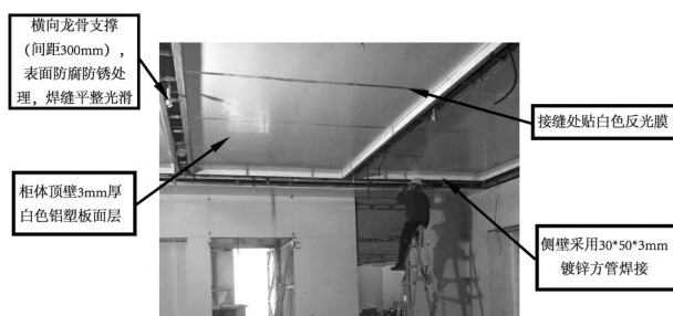
图2.4 框体现场安装图
