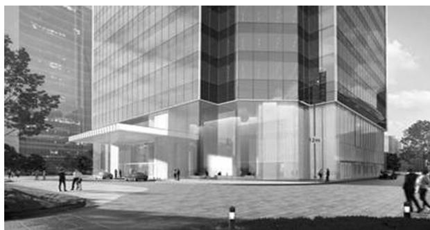
考虑中空玻璃合片时,玻璃四周的间隔条、结构胶等对立面通透性的影响,本项目首层立面玻璃采用非中空的“纯夹胶玻璃”。由于二层以上塔楼立面采用中空夹胶Low-E玻璃和双中空夹胶Low-E玻璃,因此建筑节能按建筑整体加权平均计算满足热工要求。
