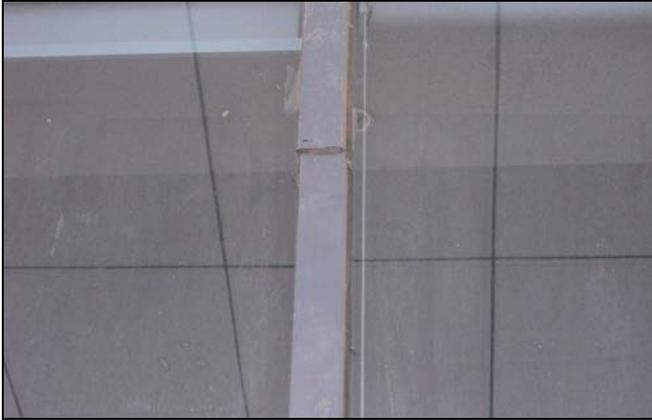
图 6-38 明框幕墙外装饰条误差较大
