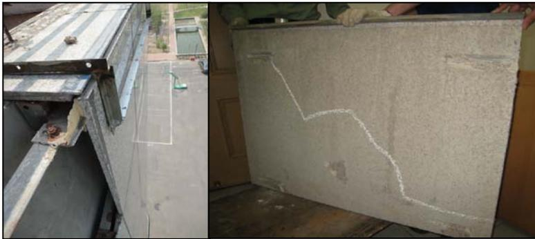
图 3-38 采用背插式挂件石材面板脱落
