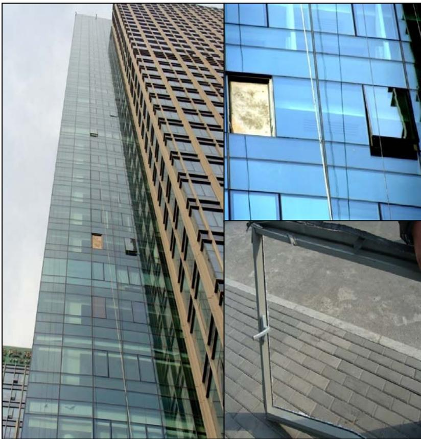
图 3-75 幕墙开启扇脱落示意
