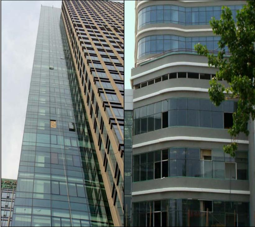
图 6-9 挂钩式开启扇脱落
