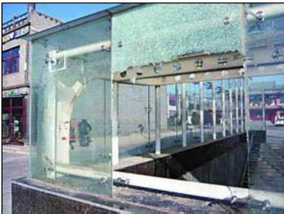
图 3-88 钢化夹胶玻璃破损脱落
