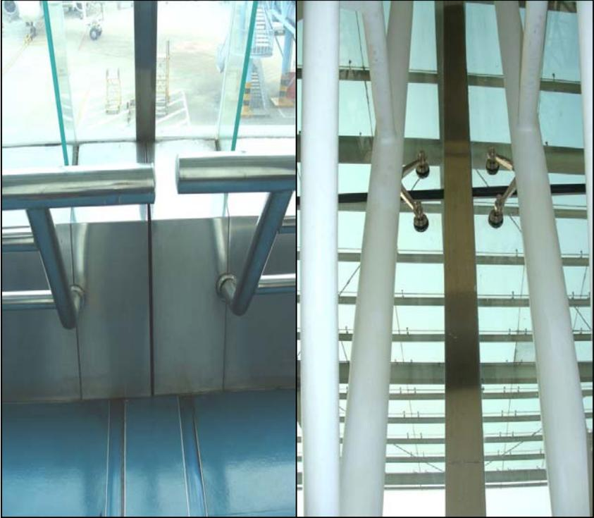
图 3-72 幕墙伸缩缝构造示意
