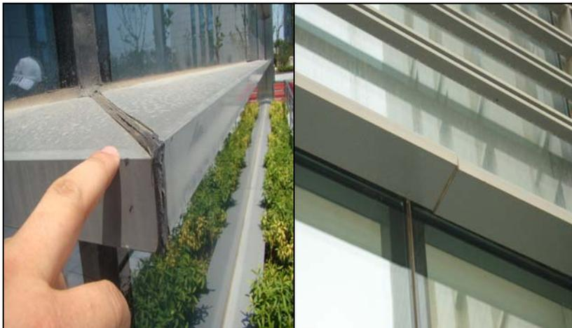
图 6-27 装饰线条平整度欠缺
