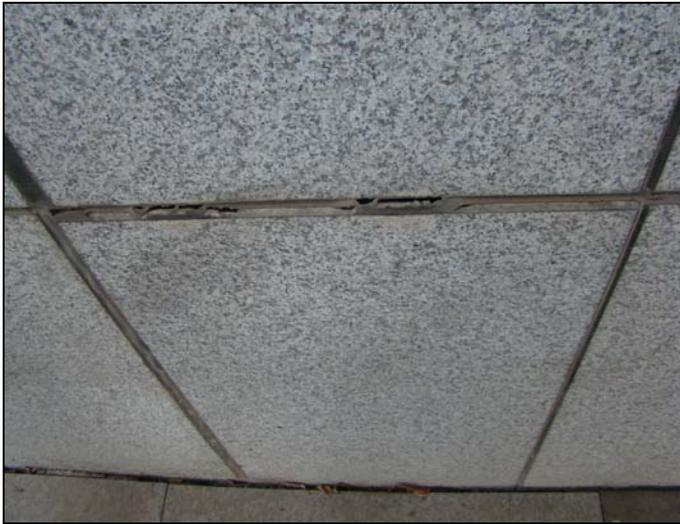
图 6-29 胶缝撕裂
