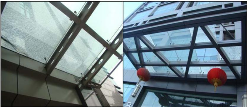
图 6-21 雨棚玻璃破损
