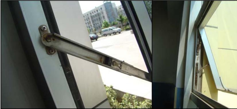
图 6-12 开启扇配件锈蚀
