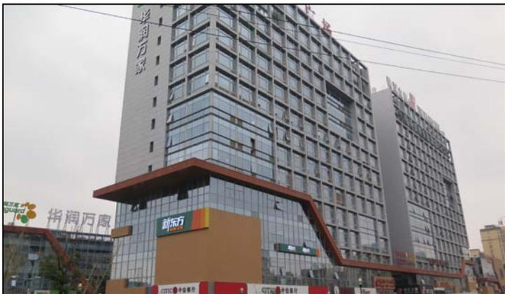
图 3-57 工程项目（局部）采用隐框玻璃幕墙
