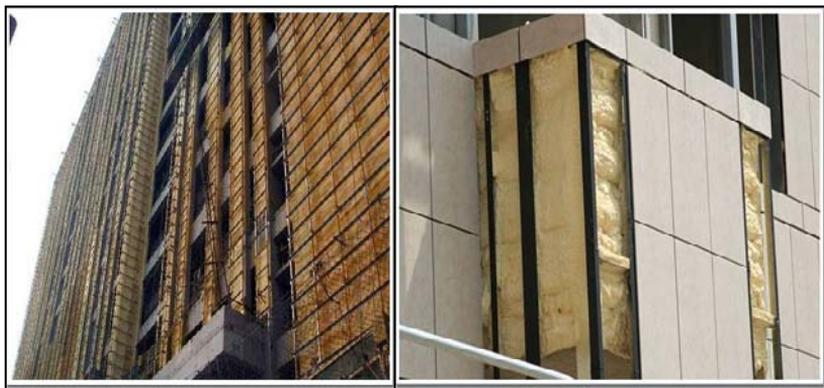
图 8-4 幕墙工程采用粘贴保温板外保温系统
