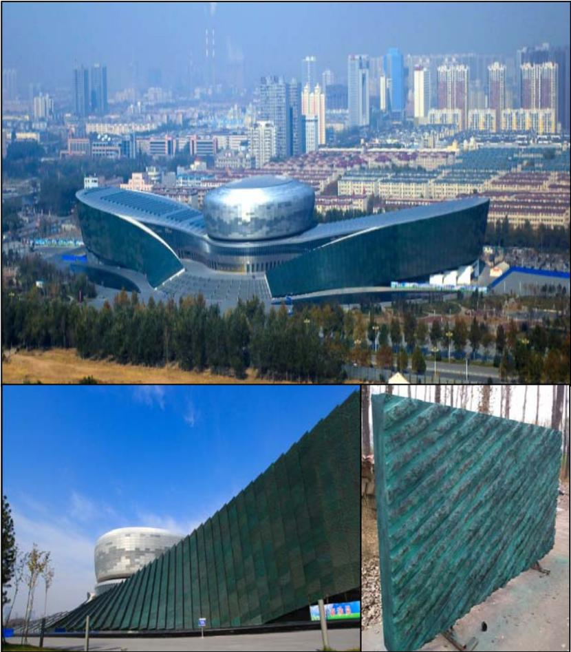
图 3-2 镀铜 GRC 板在工程中的应用（邯郸文化艺术中心）
