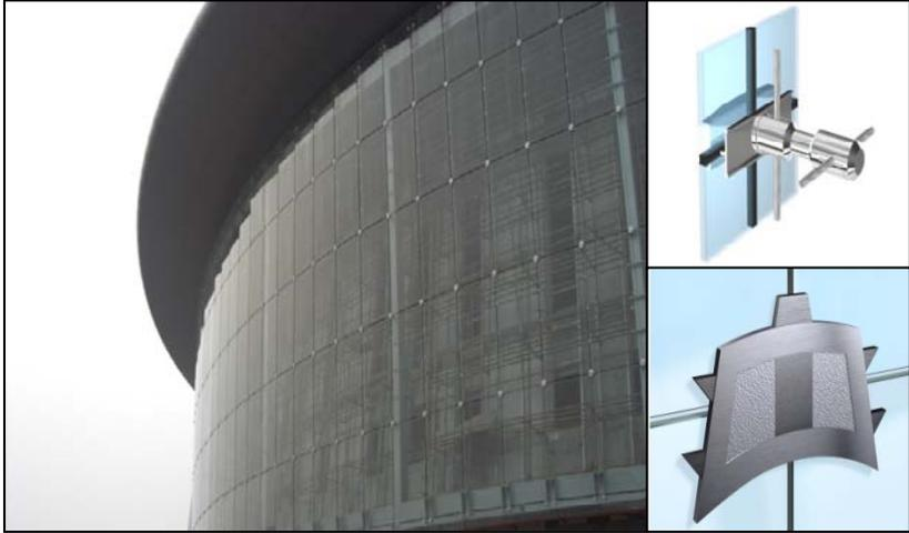
图 4-4 四点嵌固板幕墙工程实例
