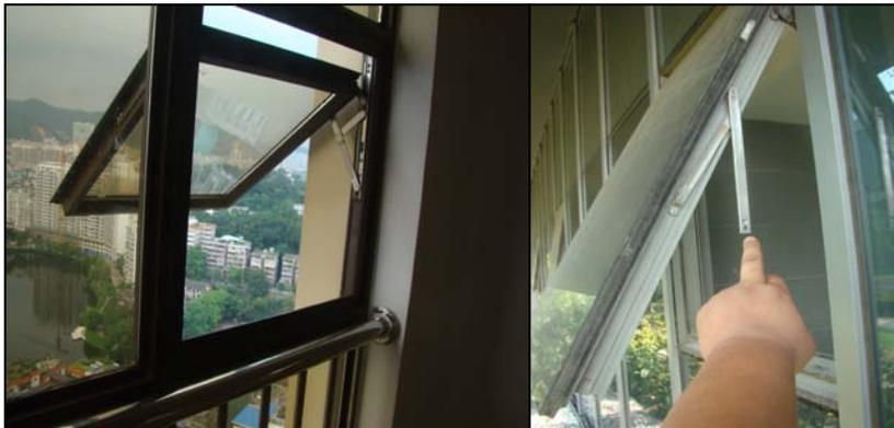
图 6-13 开启扇未加风撑或滑撑脱落
