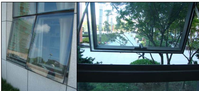
图 6-11 隐框开启扇底部未设托条
