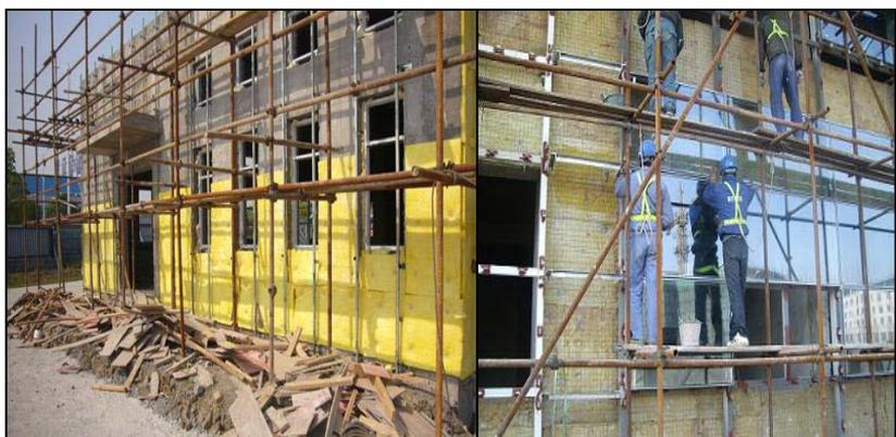
图 8-5 幕墙工程采用外墙外保温岩棉（矿棉）系统
