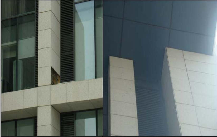
图 6-8 石材面板移位或脱落
