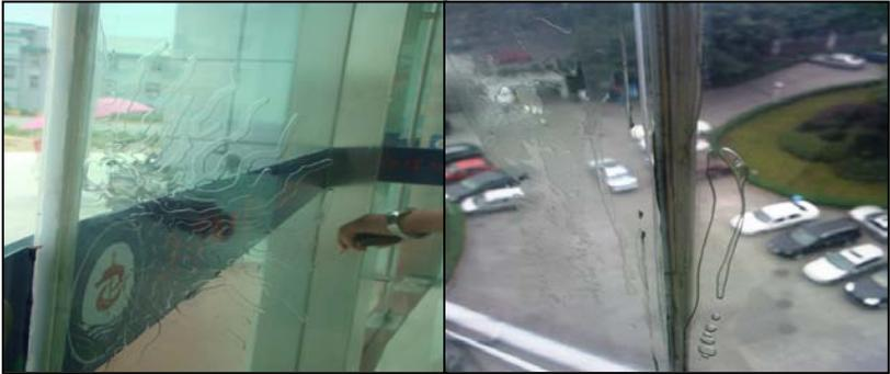
图 6-36 夹胶玻璃脱胶
