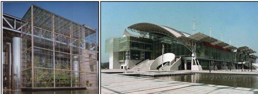
图 8-2 采用索结构支撑体系的幕墙工程
