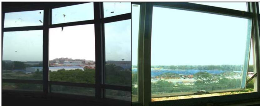
图 6-10 挂钩式开启扇脱落
