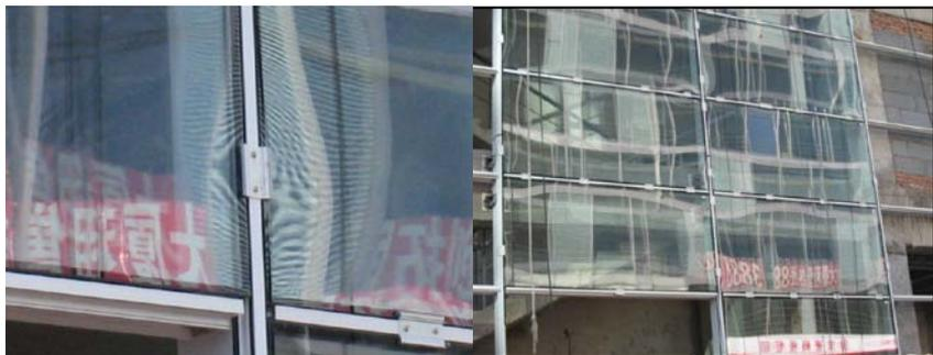
图 3-83 明框玻璃幕墙采用短压块
