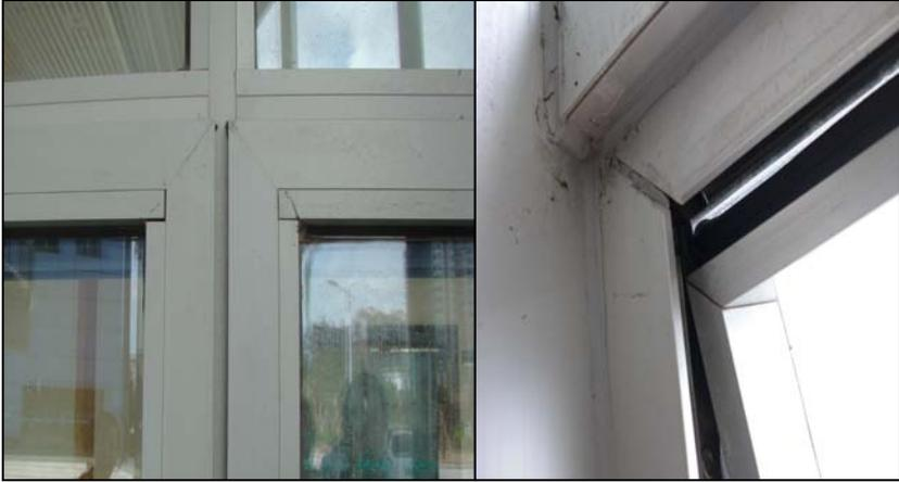
图 6-16 开启框开角间隙大
