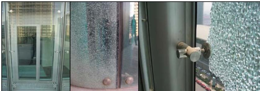
图 3-84 六点支撑玻璃破损
