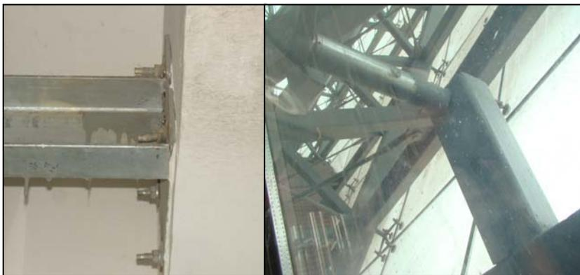
图 6-17 焊缝未焊满
