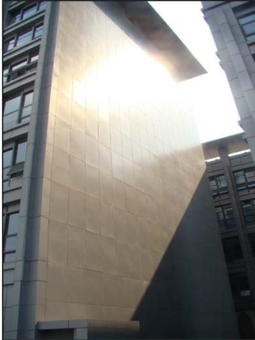
图 3-94 加强筋设置不当导致铝板幕墙表面凹凸不平
