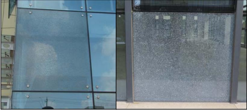
图 6-20 幕墙玻璃破损
