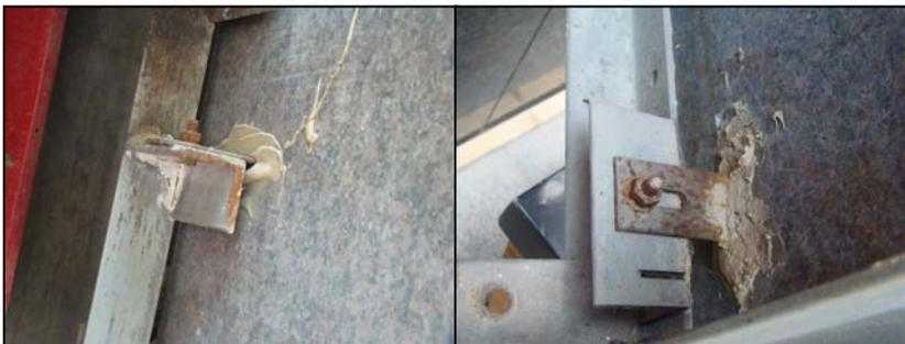
图 6-34 挂件锈蚀
