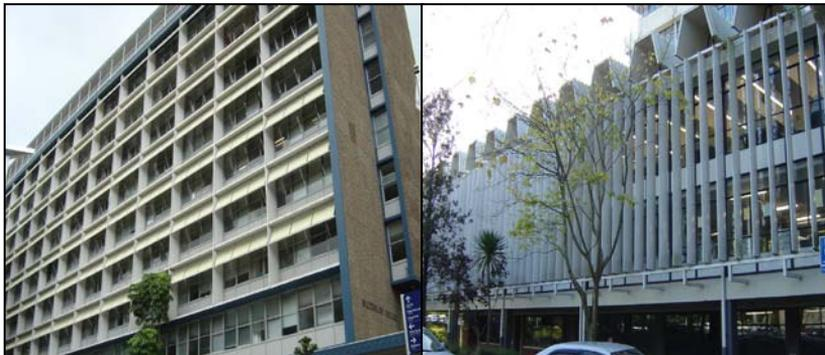
图 8-8 幕墙工程采用建筑外遮阳技术建筑外遮阳技术
