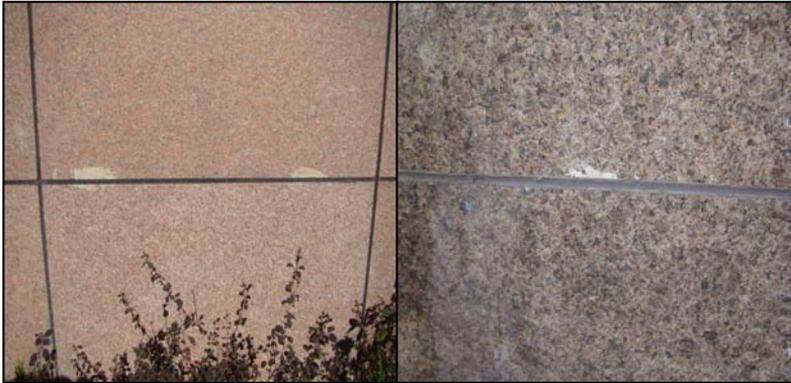
图 6-2 石材幕墙应用云石胶
