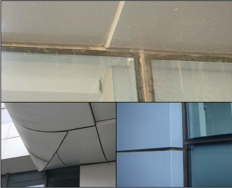
图 6-35 幕墙分格不对缝且面板不平
