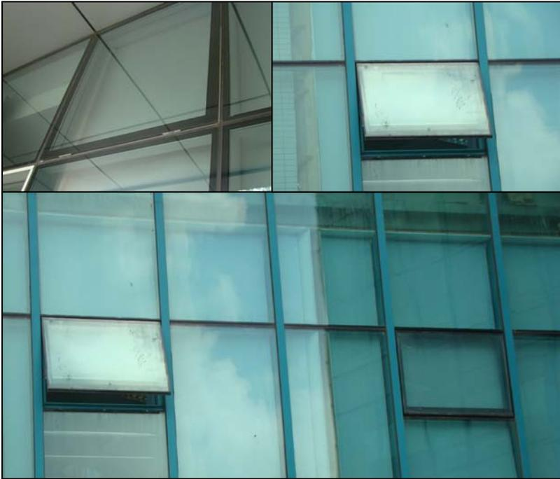
图6-15 扇框与固定框之间间隙较大
