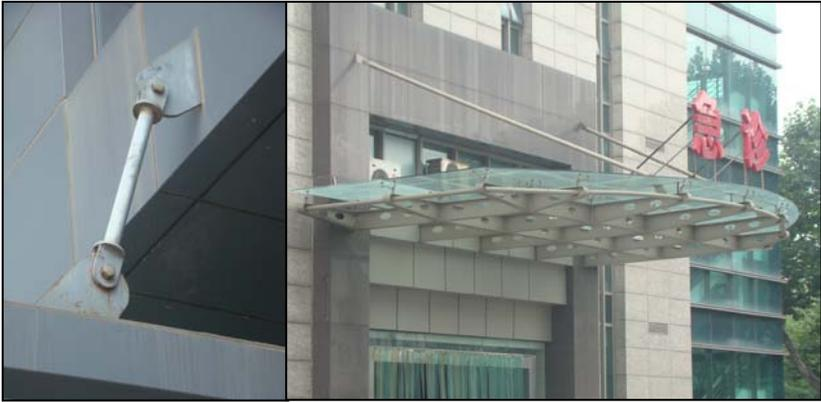
图 6-22 雨棚拉杆锈蚀
