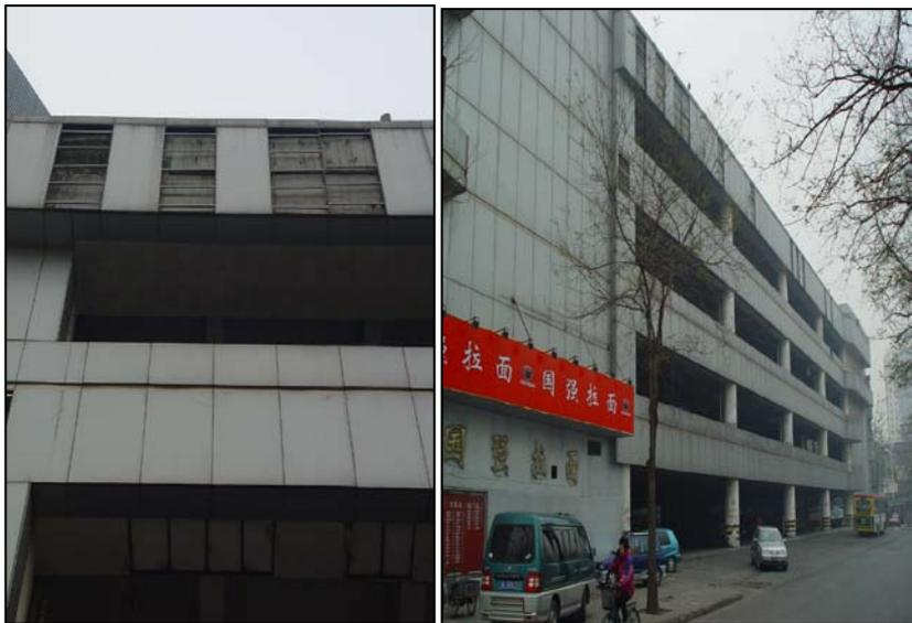
图 3-95 铝板构造不当易造成铝板脱落
