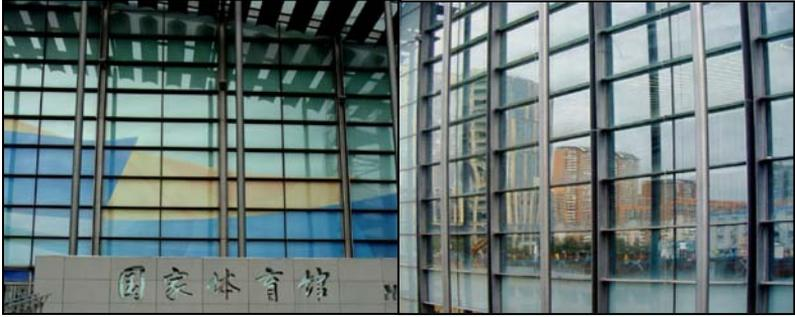
图 4-2 三边简支板幕墙工程实例
