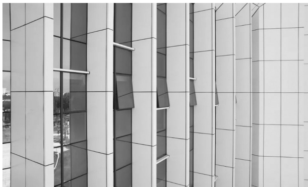
赵州城市综合馆铝板幕墙
