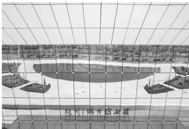
赵州城市综合馆拉索幕墙
