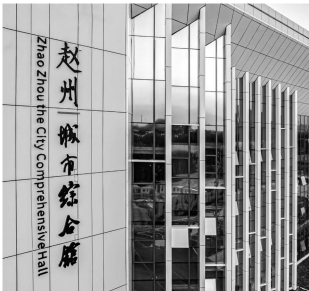
赵州城市综合馆檐口幕墙
