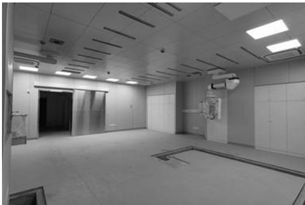
医疗设备间施工
