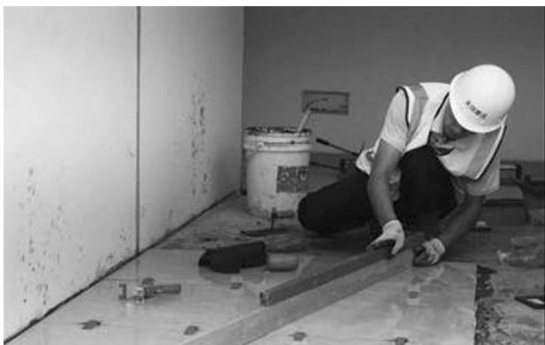
块料地面施工
